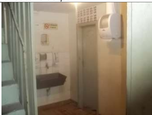
FOTO 48: Vista dos banheiros.
