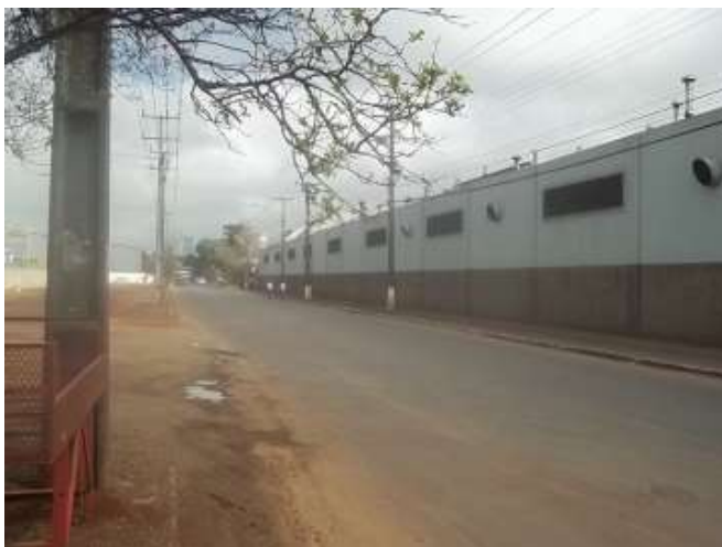
FOTO 37: Outra vista da Rua Irataúá, trecho em frente ao avaliando.
