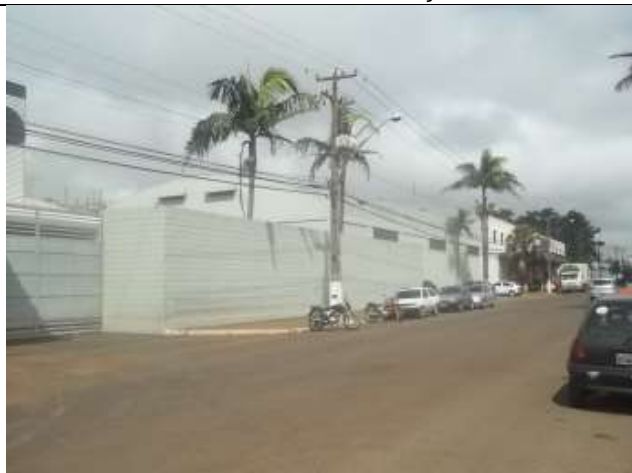
FOTO 60: Outra vista da frente do Centro de Distribuição.
