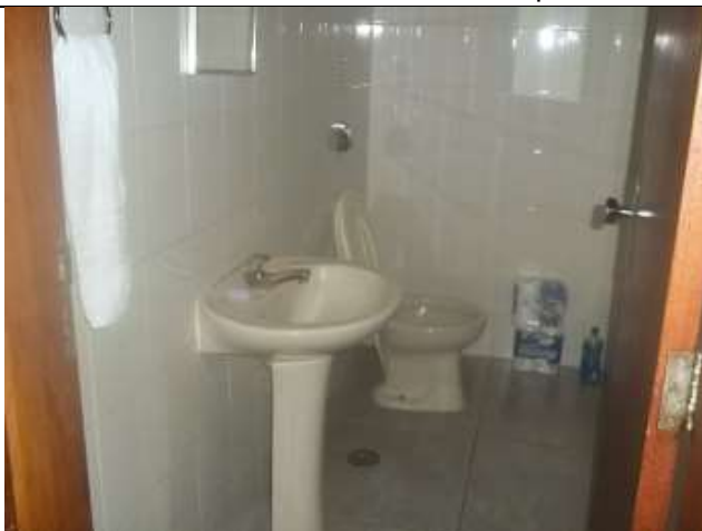
FOTO 86: Detalhe de um dos banheiros da administração.
