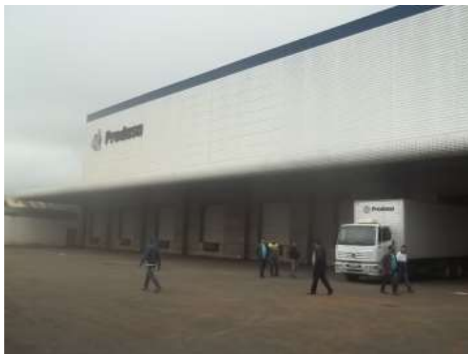
FOTO 61: Detalhe da fachada do CD.
