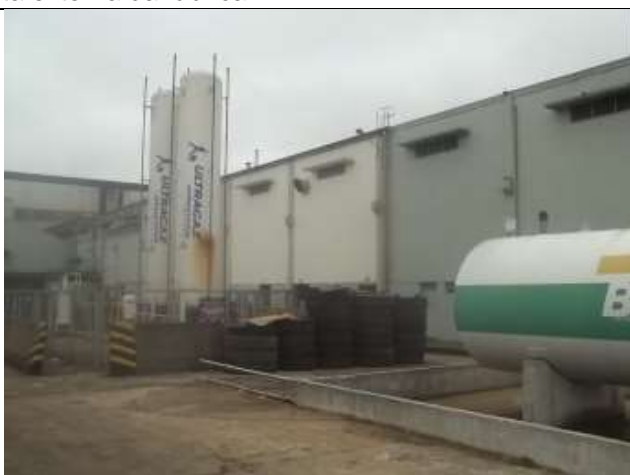
FOTO 33: Vista externa do setor de massas.
