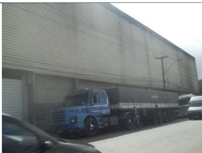
FOTO 72: Vista dos fundos do Centro de Distribuição.
