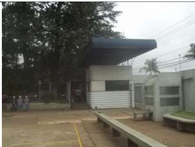
FOTO 90: Outra vista da guarita.
