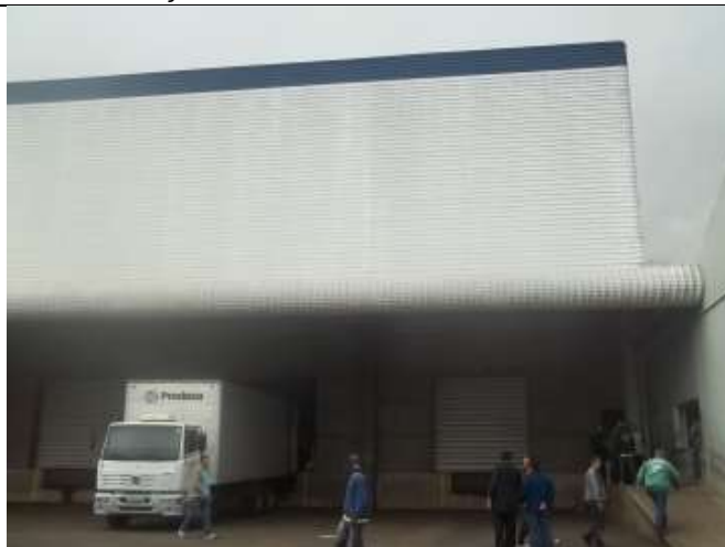
FOTO 63: Detalhe das docas do CD.
