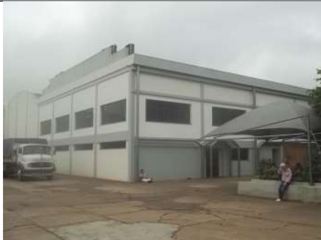
FOTO 74: Vista do prédio administrativo.
