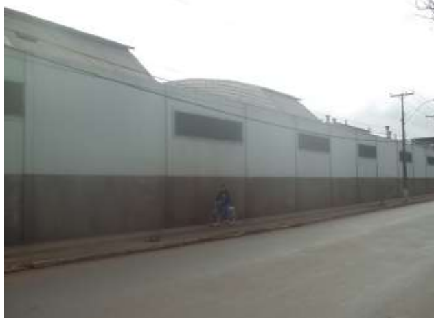
FOTO 36: Detalhe dos fundos da fábrica.
