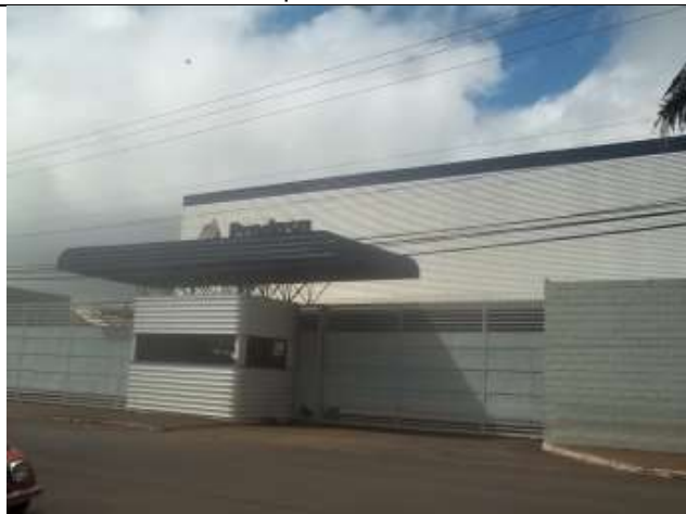
FOTO 59: Vista do acesso ao Centro de Distribuição.
