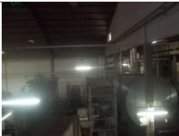
FOTO 47: Outra vista da manutenção.
