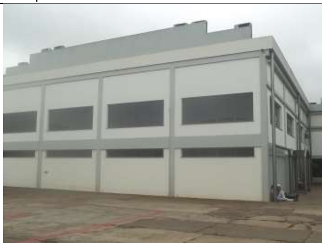
FOTO 75: Detalhe do prédio administrativo.
