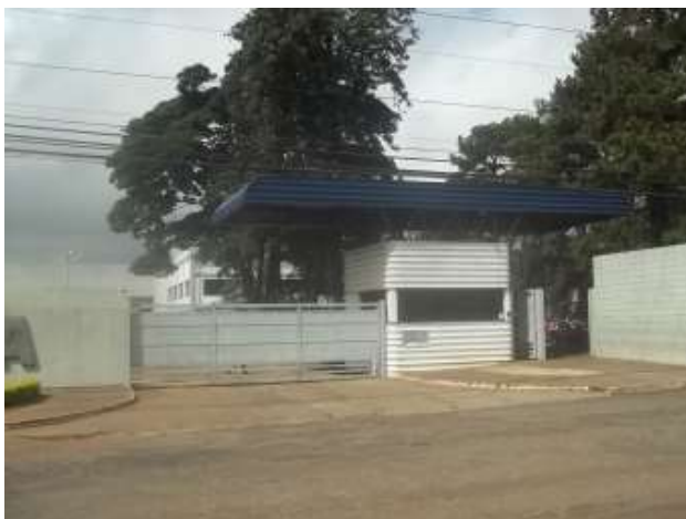
FOTO 01: Vista do acesso ao imóvel de matrícula nº. 23.863 localizado na Avenida Maracanã nº. 4.289 Bairro Parque Industrial na cidade de Arapongas/PR.
