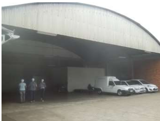
FOTO 10: Vista do galpão de acesso à fábrica.
